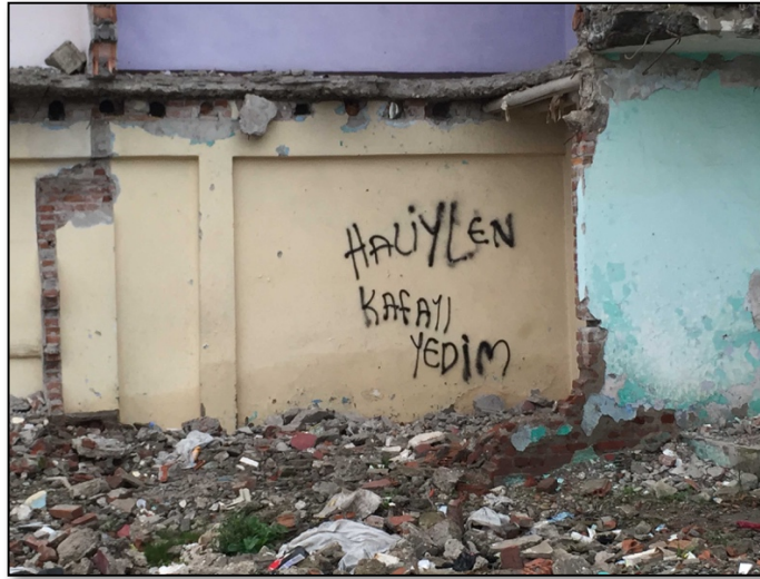
Sur’un kentsel dönüşüm yıkım alanından (Cevatpaşa, 29 Mart 2015, Fotoğraf: Çalışma Ekibi)
