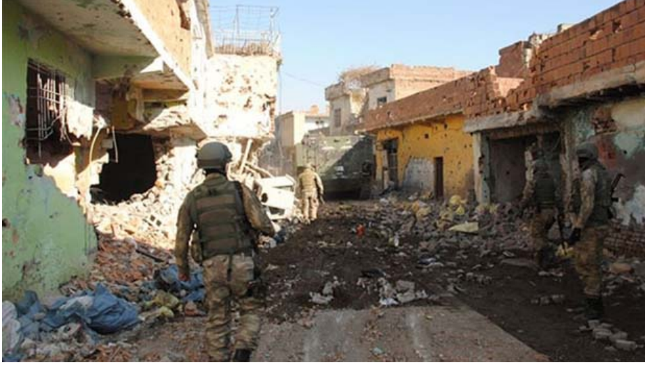
Evlerin yıkılarak dar sokakların genişletilmesi (Fotoğraf: Star Gazetesi/22 Aralık 2015)
