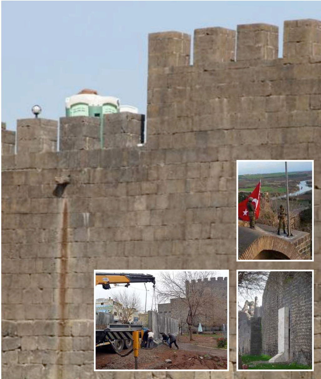
Keçi Burcu'na yapılan portatif tuvalet
