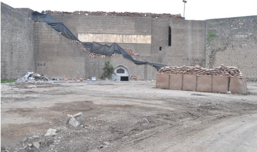
Çatışma sonrası Keçi Burcu
